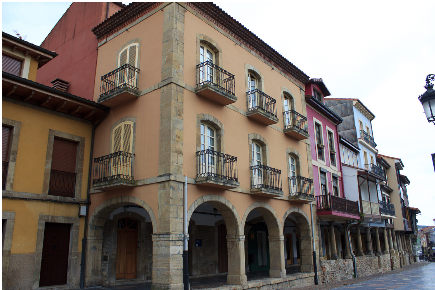
Fachadas de edificios en la calle Galiana
